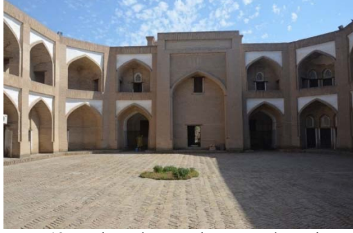
Foto-18. Arab Muhammed Han Medresesi Avlu Kuzey Duvarı (E, POLAT, 2018)
