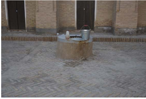
Foto-14. Arab Muhammed Han Medresesi Avlu İçerisindeki Kuyu (E, POLAT, 2018)
