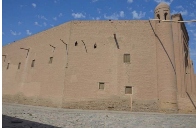
Foto-2. Arab Muhammed Han Medresesi Kuzeydoğu Cephesi (E, POLAT, 2018)
