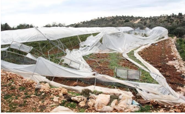
Resim 2: Erdemli Üçtepe Mahallesinde Fırtına nedeniyle Zarar Gören Seralar
