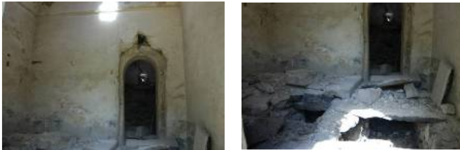
Foto 38-39: Hamamın Sıcaklık Mekânı
