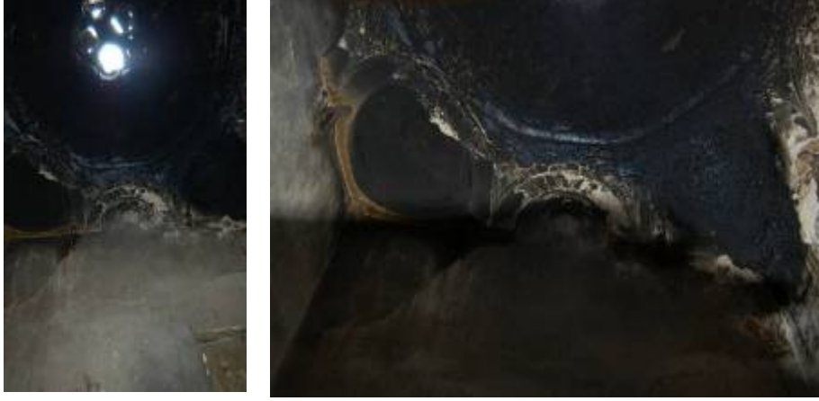
Foto 66-67: Osman Çetin Evi Hamamı Kubbe ve Kubbeye Geçiş
