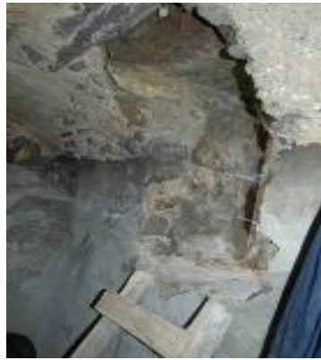
Foto 56-57: Germir Sadık Çelen Konağı Hamamı Su Deposu
