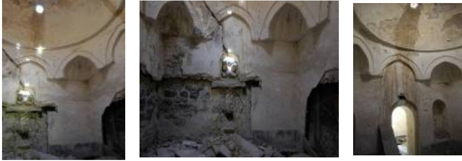
Foto 40-41-42: Hamamın Sıcaklık Mekânının Üst Örtüsü
