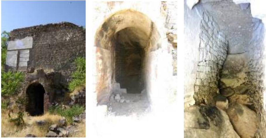
Foto 46-47-48: Hamamın Güney Cephesinde Bulunan Külhanı
