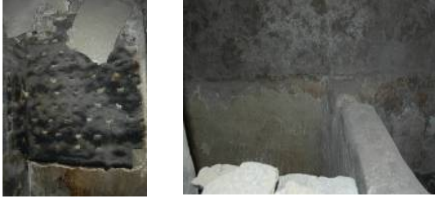
Foto 71-72: Osman Çetin Evi Hamamı, Duvar Kaplaması ve Su Deposu
