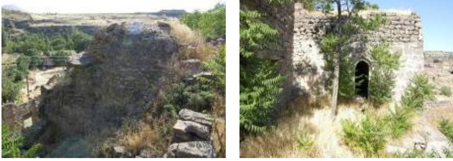
Foto 33-34: Bektaşoğlu Konağı Hamamı Girişi
