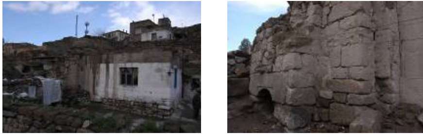
Foto 73-74: Osman Çetin evi Hamamı, Duvar Kaplaması ve Su Deposu
