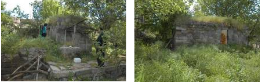
Foto 54-55: Germir Sadık Çelen Konağı Hamamı Su Deposu
