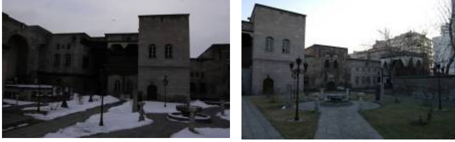
Foto 7-8: Güpgüpoğlu Konağı Kuzey Cephesi
