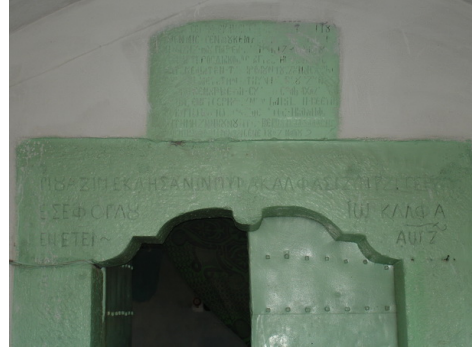
Fotoğraf 8: Niğde Yeşilburç Köyü Camiye Çevrilen Kilise Kitabesi
